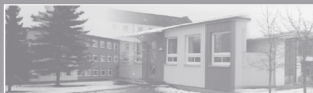
Das Schulgelände der Staatlichen Grund- und Regelschule „Wilhelm Hey“ Ichtershausen
